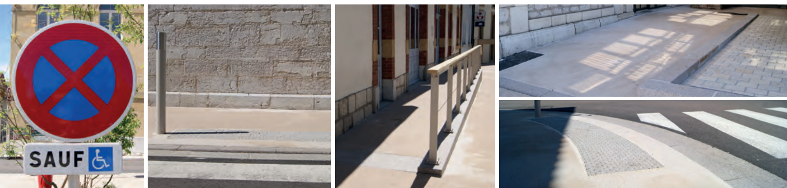
Pavés podotactiles, rampe d'accès,...
