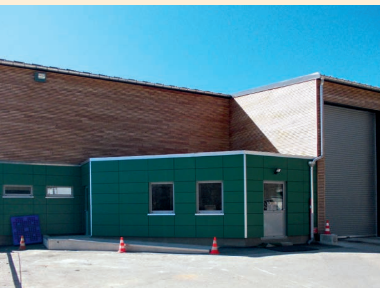
Bâtiments rénovés de la déchèterie
