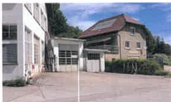
AU CENTRE, LE HANGAR VIDE D'OCCUPATION À L'ENDROIT DE LA NOUVELLE VOIE D'ACCÈS / EMPRISE FONCIÈRE COMMUNALE
