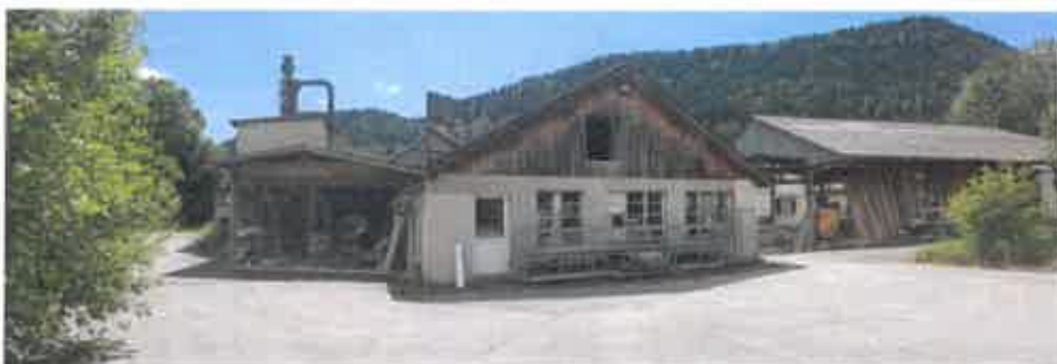
VUE DEPUIS LE NIVEAU HAUT DE LA ZONE UZ
