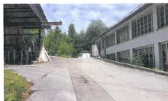
LE PASSAGE DE L'ER 14, QUI DIVISE L'ACTUEL SITE D'ACTIVITÉS - VUE DEPUIS LA RD 215
