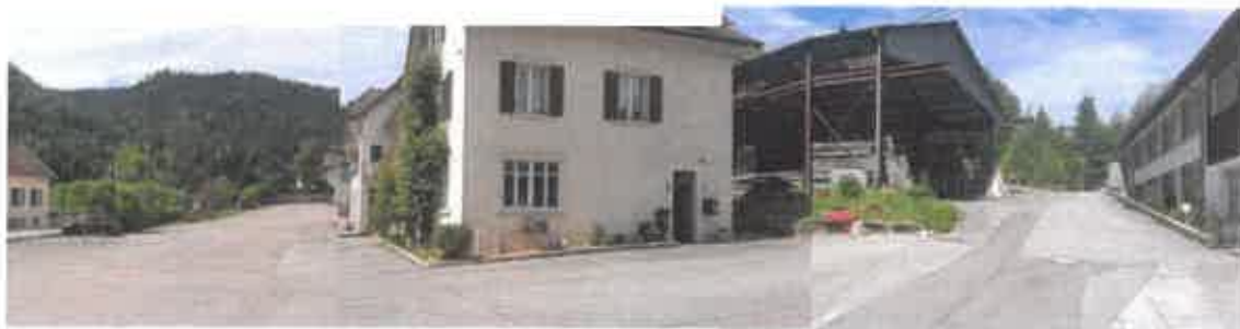
VUE DEPUIS LA RD 215 ET MONTÉE DE L'ER14, À DROITE DE L'IMAGE
