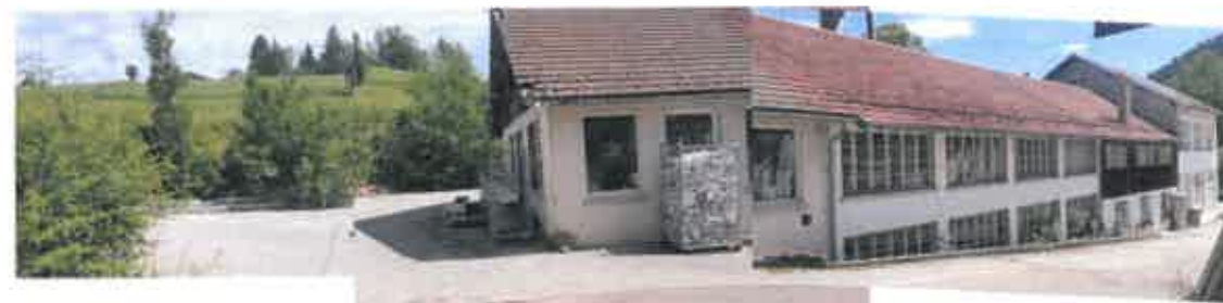
VUE DEPUIS LE NIVEAU HAUT DE LA ZONE UZ À GAUCHE, LE PASSAGE DE LA NOUVELLE EMPRISE FONCIÈRE, À DROITE LE PASSAGE DE L'ER14
