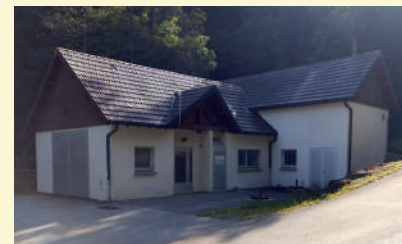
Station de filtrage eau - Montlebon
