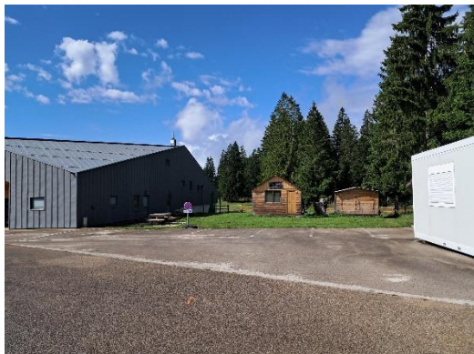
Vues des bâtis légers (Nord-Est)
