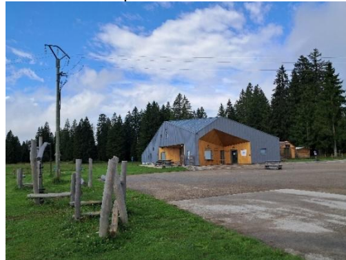
Vue du bâti depuis le sentier en tout venant (Sud)
