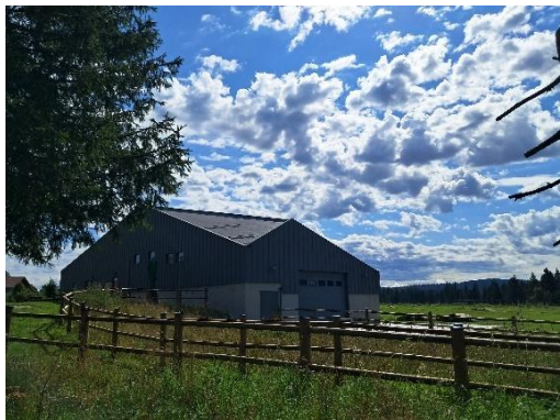
Vue du bâti depuis la route (Nord)
